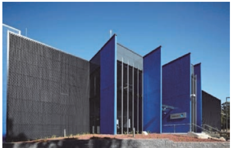
Intellicentre 2 (シドニー、オーストラリア) データセンター
