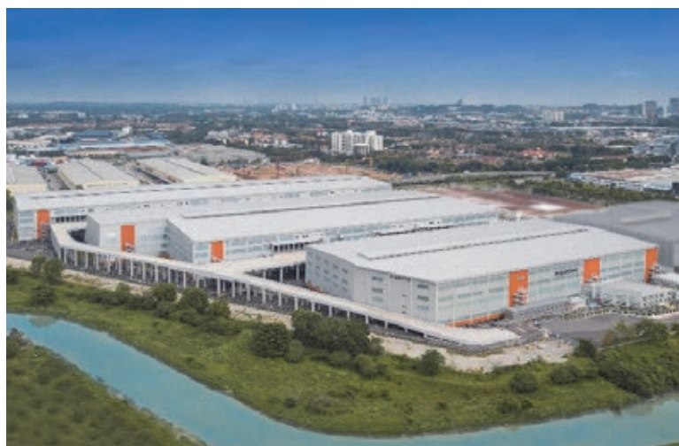
Mapletree Logistics Hub - Shah Alam (シャーアラム、マレーシア) 倉庫
